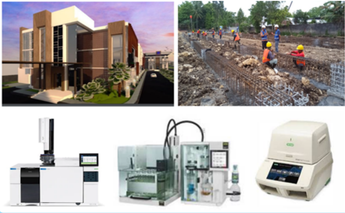
Gambar 3.29 Pembangunan Infrastruktur Fasilitas Laboratorium Proses Pangan Tradisional Berstandar c-GMP
