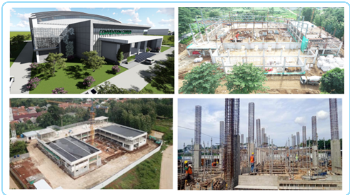
Gambar 3.28 Pembangunan Laboratorium Infrastruktur Produktif Cibinong Science and Technology Park (C-STP)
