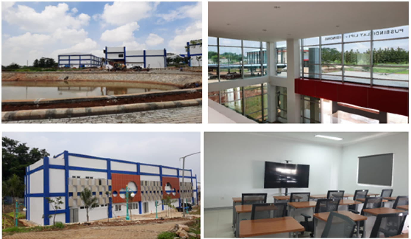
Gambar 3.31 Pembangunan Infrastruktur Produktif C-STP (Luncuran Tahun 2019)
